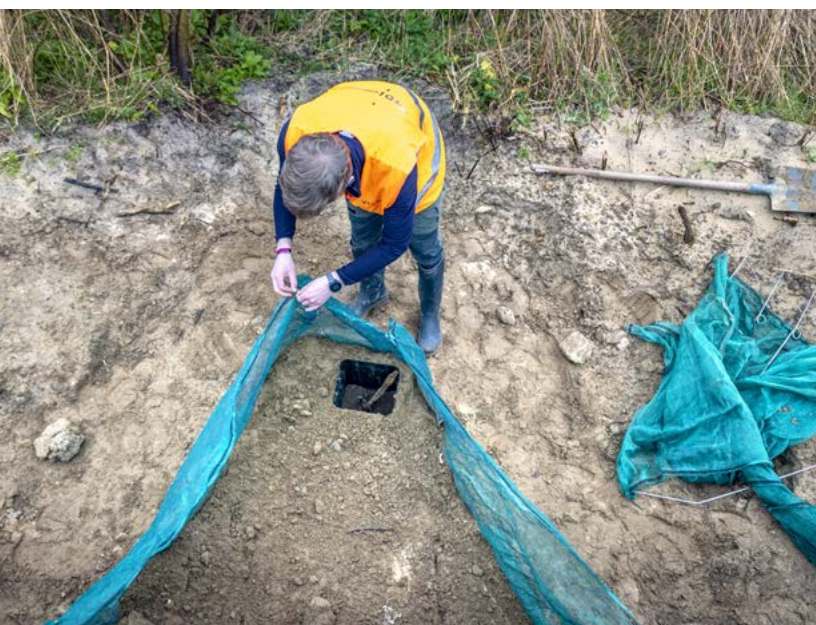
Installation d'un passage pour la petite faune RD 940, dunes de la Slack
