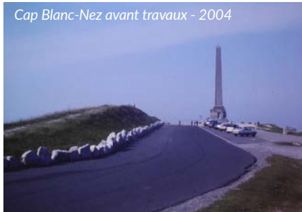
Cap Blanc-Nez avant travaux - 2004
