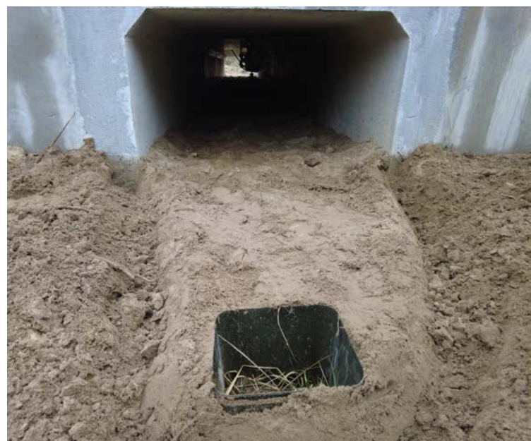
Installation d'un passage pour la petite faune RD 940, dunes de la Slack
